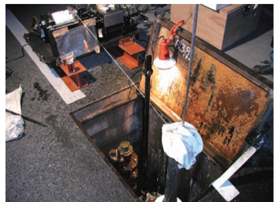
図9 実管路調査状況
