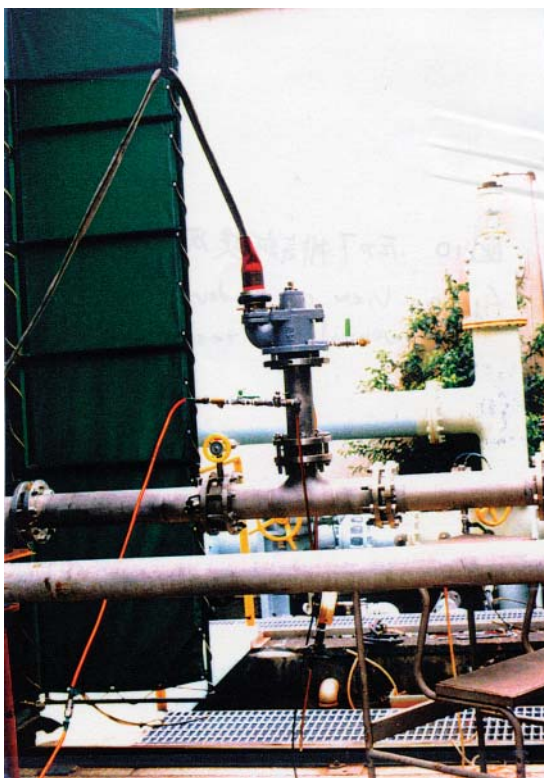
図10 圧力下排気試験風景
