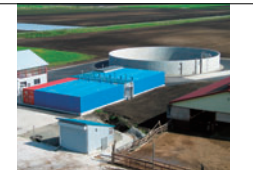
バイオガスプラント
