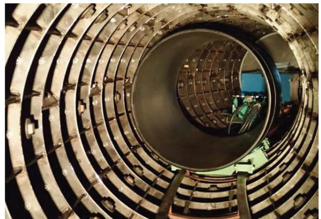
図13 曲管 (さや管と逆曲り) の急曲線部通過状況
