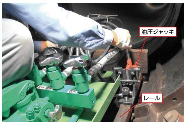
図 17 油圧ジャッキによる挿し口の挿入状況
