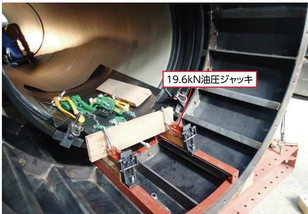
図29 直管の挿し口挿入状況
