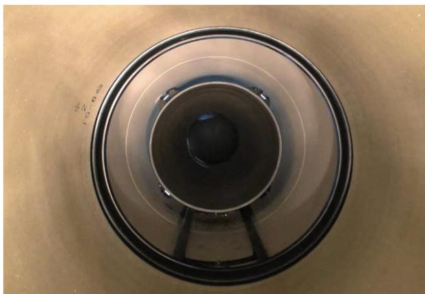
図23 接合相手の受口内面から見た挿し口の状況
