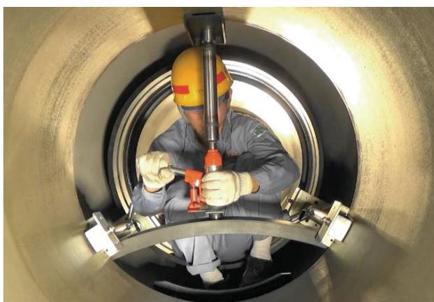
図24 挿し口内面から見た挿し口持ち上げ状況
