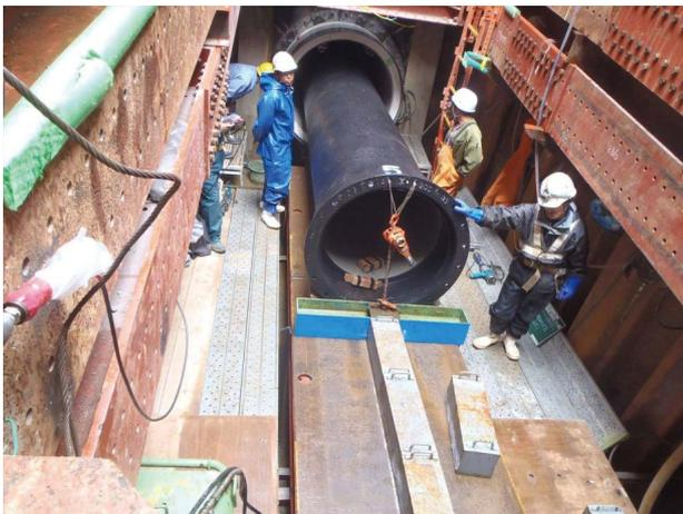
**図6 NS形管の挿入状況**
