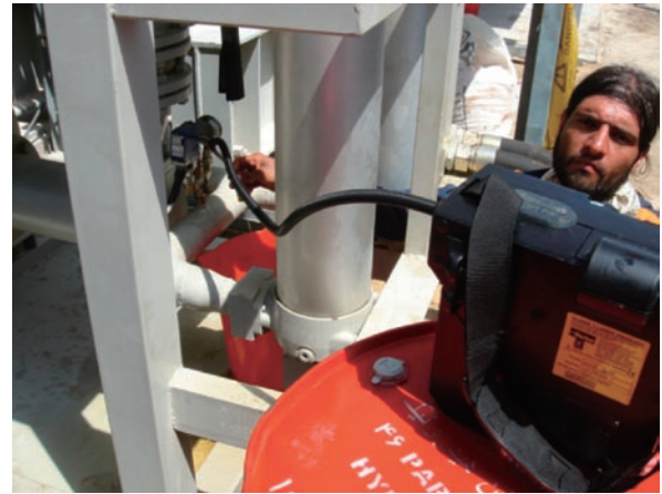
図8 フラッシング 清浄度確認状況写真
