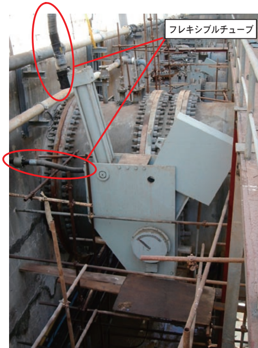
図7 シリンダ接続部写真(φ3,500)
