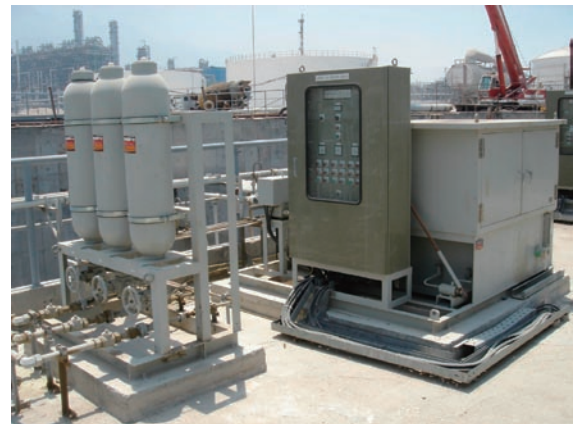
図9 油圧ユニット(φ1,800バタフライ弁)
