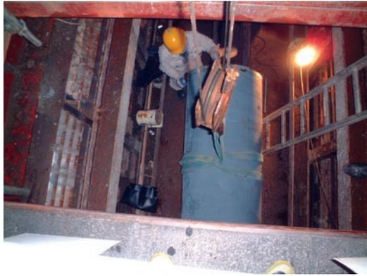
図7 鋼管吊込み
