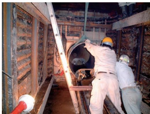
図5 鋼管挿入
