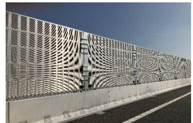
「点検口付き金属製遮音板」
