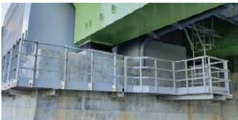
「主桁・床版一体型 FRP 検査路」
