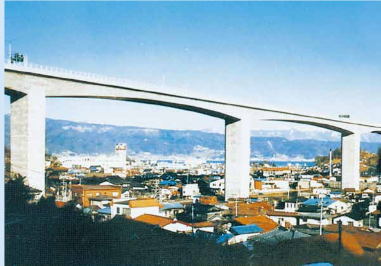
中央自動車道長野線(岡谷高架橋) 橋長600m 天竜川、国鉄中央線、岡谷市街地、県道等を地上55mの高さで一気にまたぐPC連続桁タイプとして、橋長日本有数のラーメン橋です。
