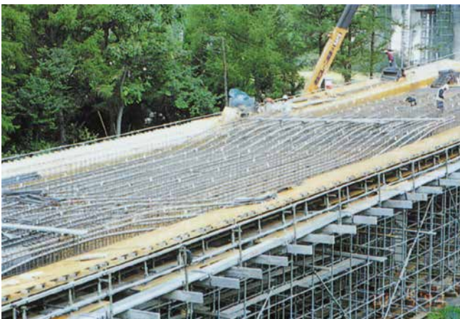
長野県、角間橋
