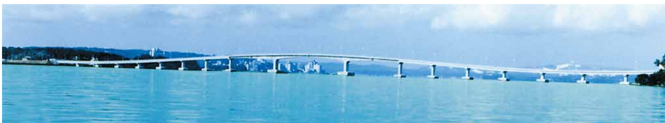
石川県、能登島大橋 全長1,050m、中央スパン262m
