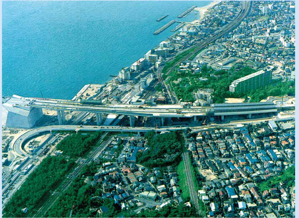
本州四国連絡橋公団(舞子高架橋) 神戸市垂水区舞子台
