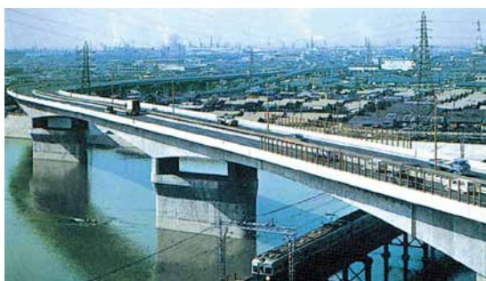
阪神道路公団、大和川橋梁 全長602m、主径間120m
