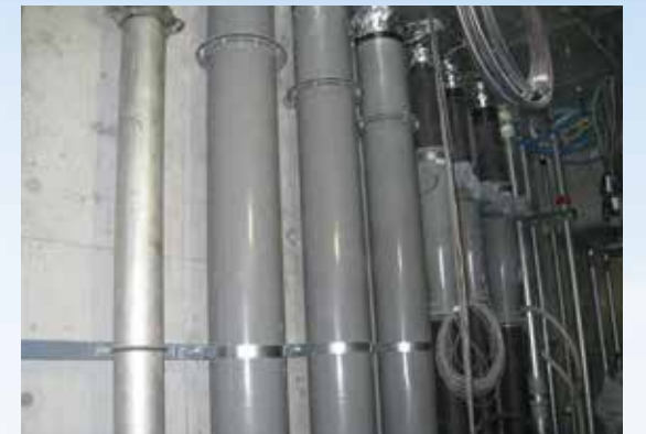
臭突管施工例
