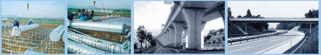
据付中の円筒型枠
