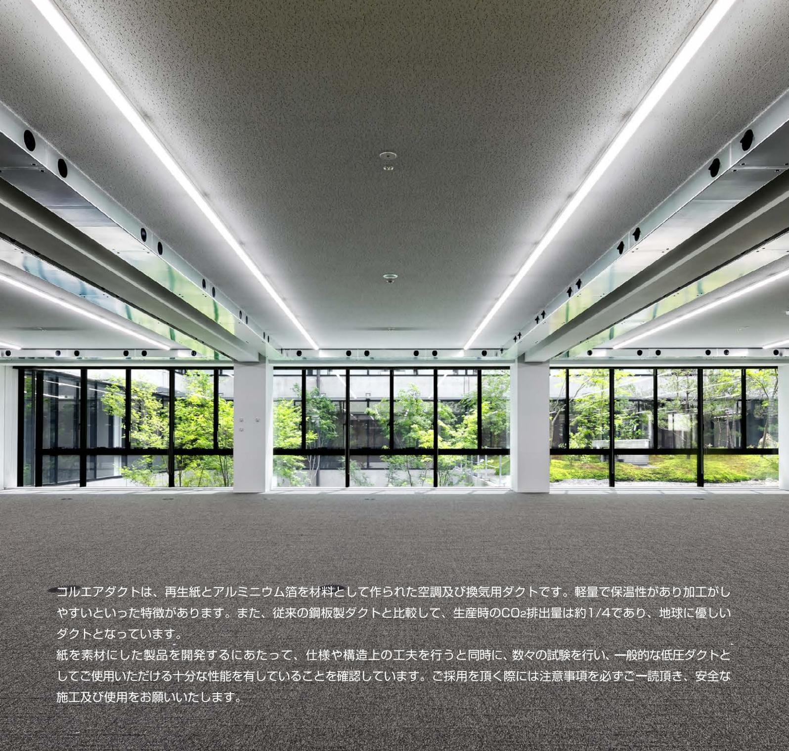
コルエアダクトは、再生紙とアルミニウム箔を材料として作られた空調及び換気用ダクトです。軽量で保温性があり加工がしやすいといった特徴があります。また、従来の鋼板製ダクトと比較して、生産時のCO<sub>2</sub>排出量は約1/4であり、地球に優しいダクトとなっています。
