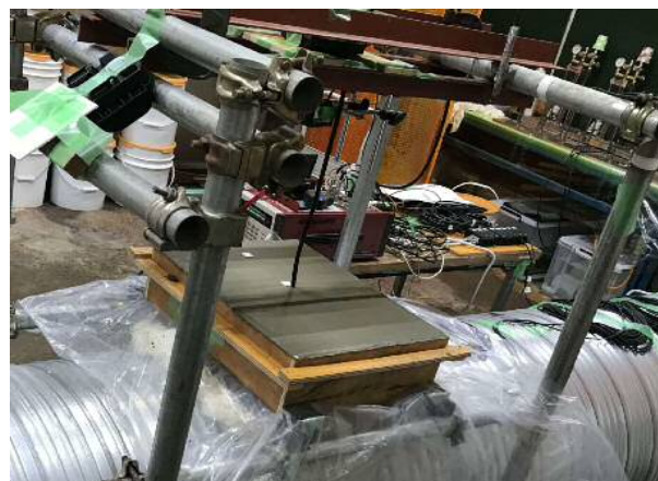
3. コンクリート打設試験状況
