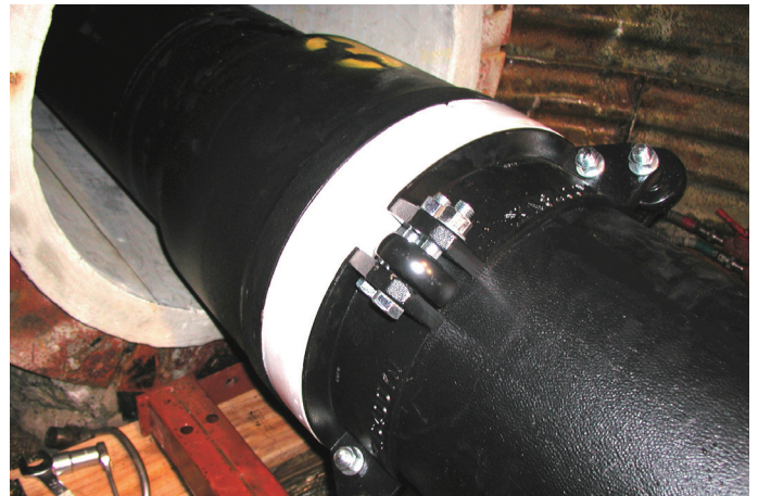
●NS形推進力伝達リング装着状況
