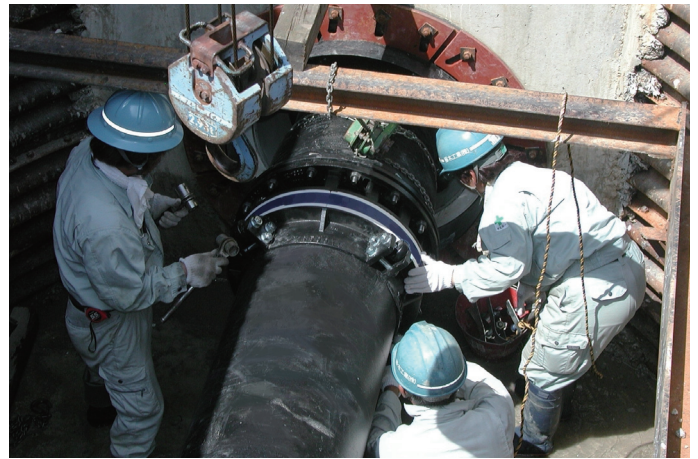
●NS形施工状況
