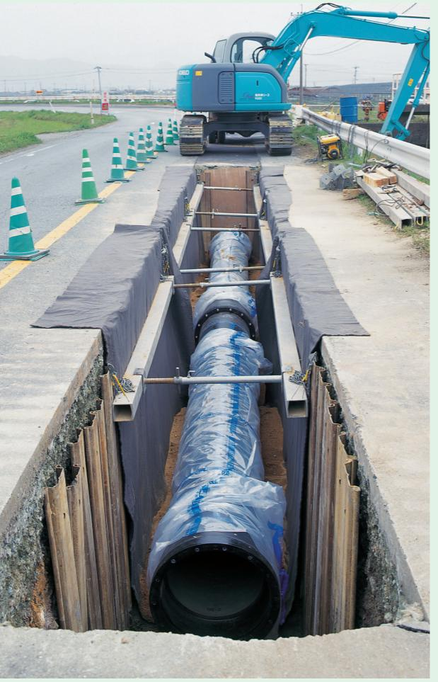
ダクタイル鉄管を保護するポリエチレンスリーブ工法
