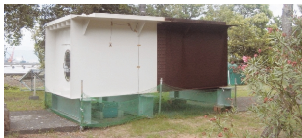
東京商船大学清水試験場(静岡県)に設置した実証実験桁
