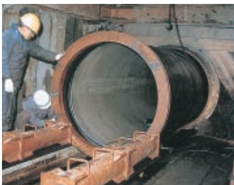
既設管の中に新管を挿入
