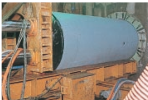
推進工法用ダクティル鉄管
